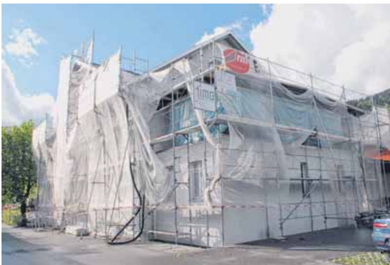
Der Umbau der ehemaligen Bahnhofs-Restoration geht in die Endphase.
